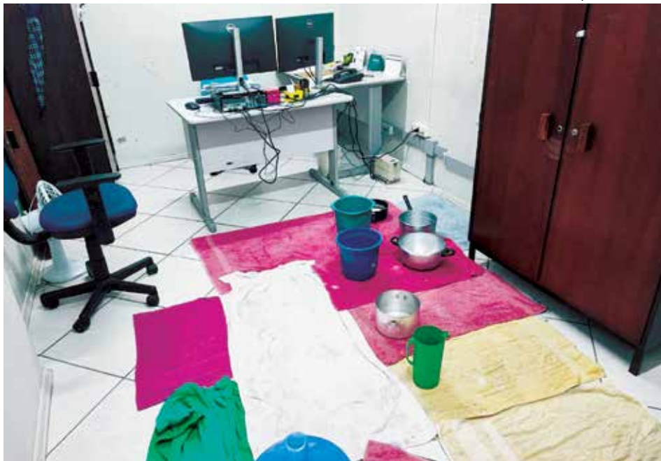
Baldes, panelas e toalhas passaram a fazer parte do cotidiano dos policiais civis de Caxias do Sul
